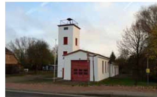
Das Feuerwehrhaus in Rolofshagen 2014
