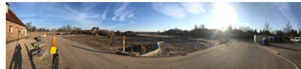
Ein neues Baugebiet entsteht (Foto: Frühling 2018)
