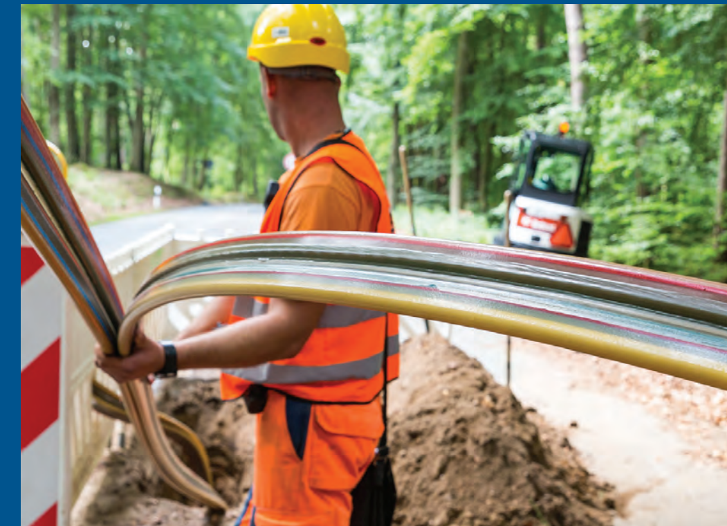
Auch in Damshagen beginnen demnächst die Bauarbeiten für ein schnelles Glasfaserinternet. Foto: WEMAG/Stephan Rudolph-Kramer
